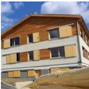
[Bureaux ] LowCal Bureaux bois-paille, sans chauffage, à énergie positive, 1 er labelisé E+C- Maître d'ouvrage : Scop ENERTECH / Architecte : cabinet Traversier
